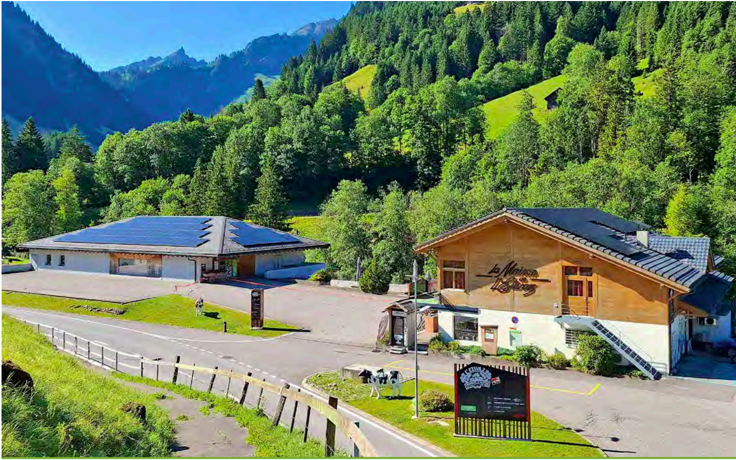
La Maison de L'Étivaz, située sur les caves à fromage, est déjà bien dotée en panneaux photovoltaïques. La participation de la Coopérative à AgrolImpact s'inscrit parfaitement dans une longue histoire.
